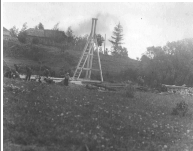
Строительство плотины. П. Красный. 1957 год.
